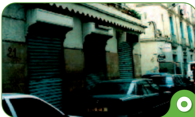
Rue Tanger en cours de réhabilitation dans le cadre d'une coopération Alger-Paris
